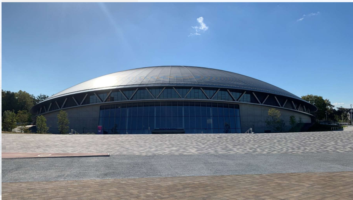
メインエントランス側
